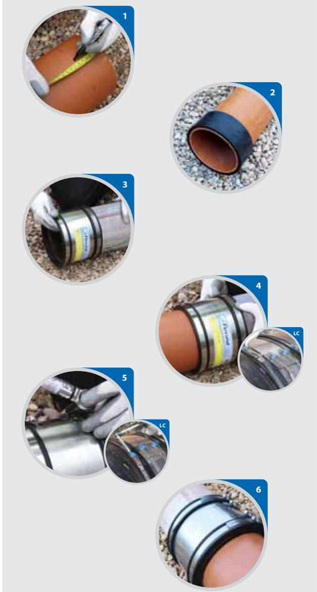
Mesurer la largeur du raccord et tracer un repère, sur les deux tubes à raccorder, correspondant à la moitié de la largeur du raccord.
